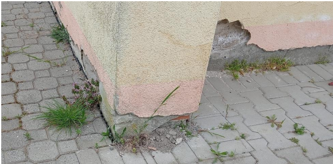
Ryc. 19 Budynek OSP w Mochach
